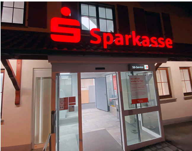
Die Geschäftsstelle der Sparkasse Zollernalb in Lautlingen wird nach der Renovierung ab 11. Februar wiedereröffnet. Ein hochwassersicherer Vorraum mit Schutztür verhindert künftig bei starken Unwettern das Eindringen von Schmutz und Dreck in die gesamte Geschäftsstelle.
